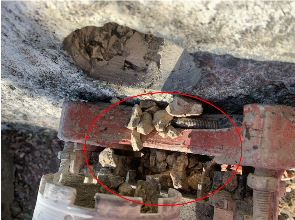
Abbildung 32: Bohrloch Bohrkern BK11
