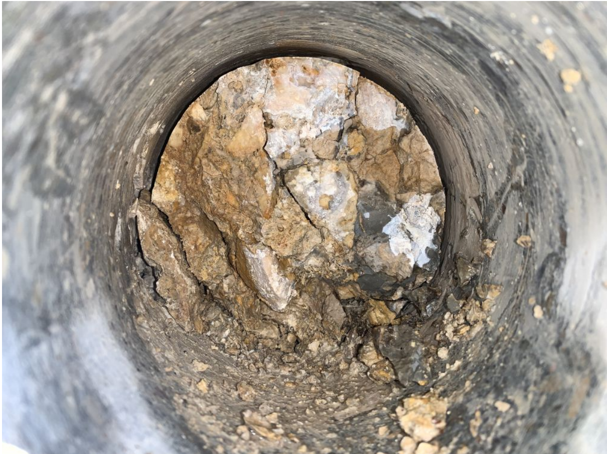
Abbildung 33: Bohrloch Bohrkern BK12
