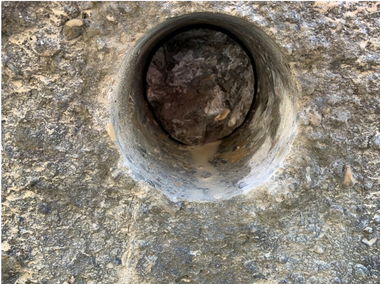
Abbildung 30: Bohrloch Bohrkern BK10
