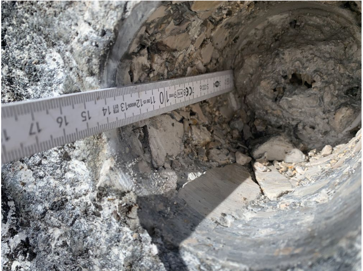
Abbildung 31: Bohrloch Bohrkern BK11
